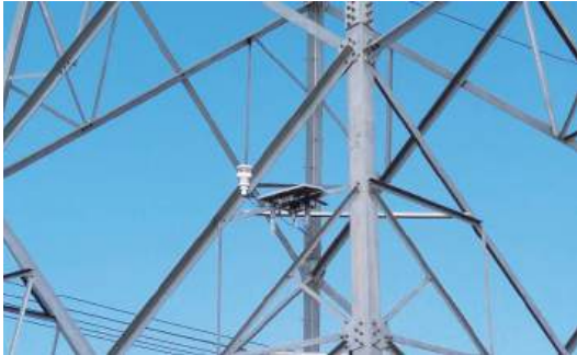
微气象在线监测装置现场安装图
